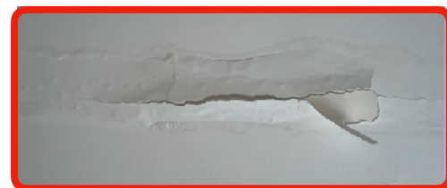
PLAFOND D'UN DES APPARTEMENTS
